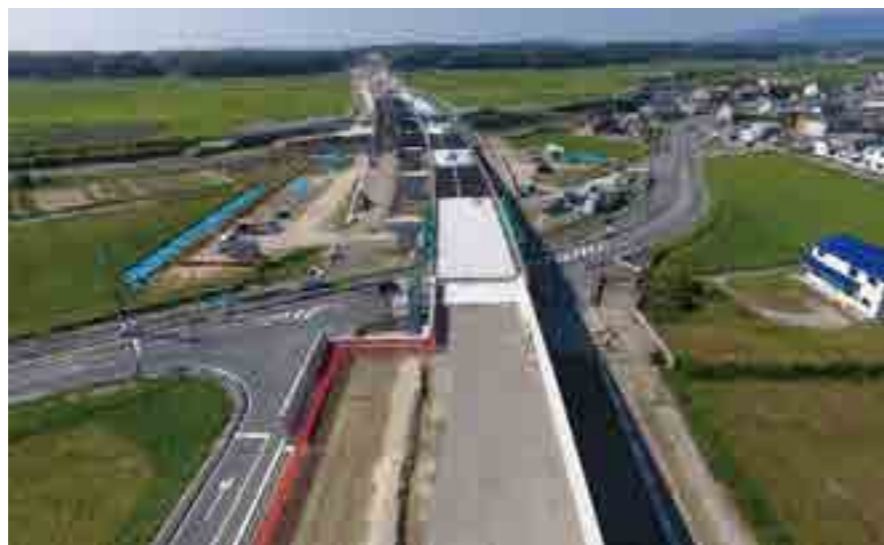
完成直前の中勢バイパス津鈴鹿工区
